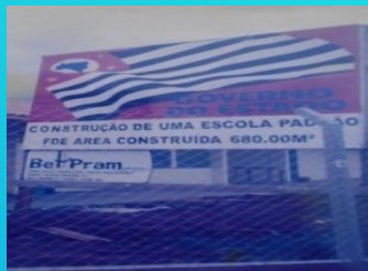
Placa da Obra de Construção do novo Prédio
